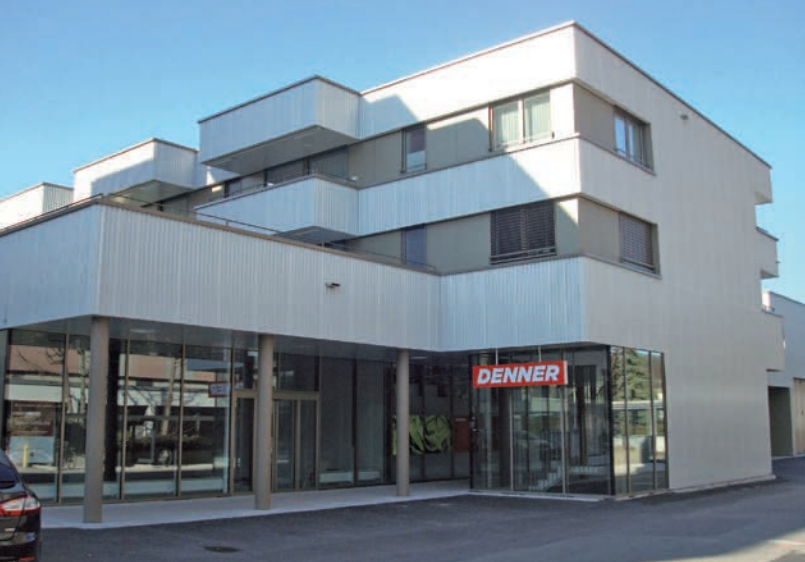
Nouvelle construction à Therwil (BL) avec des logements et des surfaces commerciales au rez-de-chaussée.
