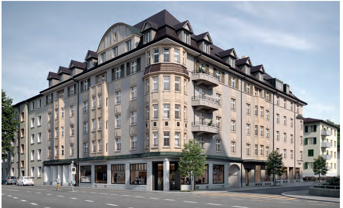
St. Gallen, Grossackerstrasse 1+3 / Falkensteinstrasse 15+17 / Rorschacher Strasse 120+122 / Neptunstrasse 2+4
