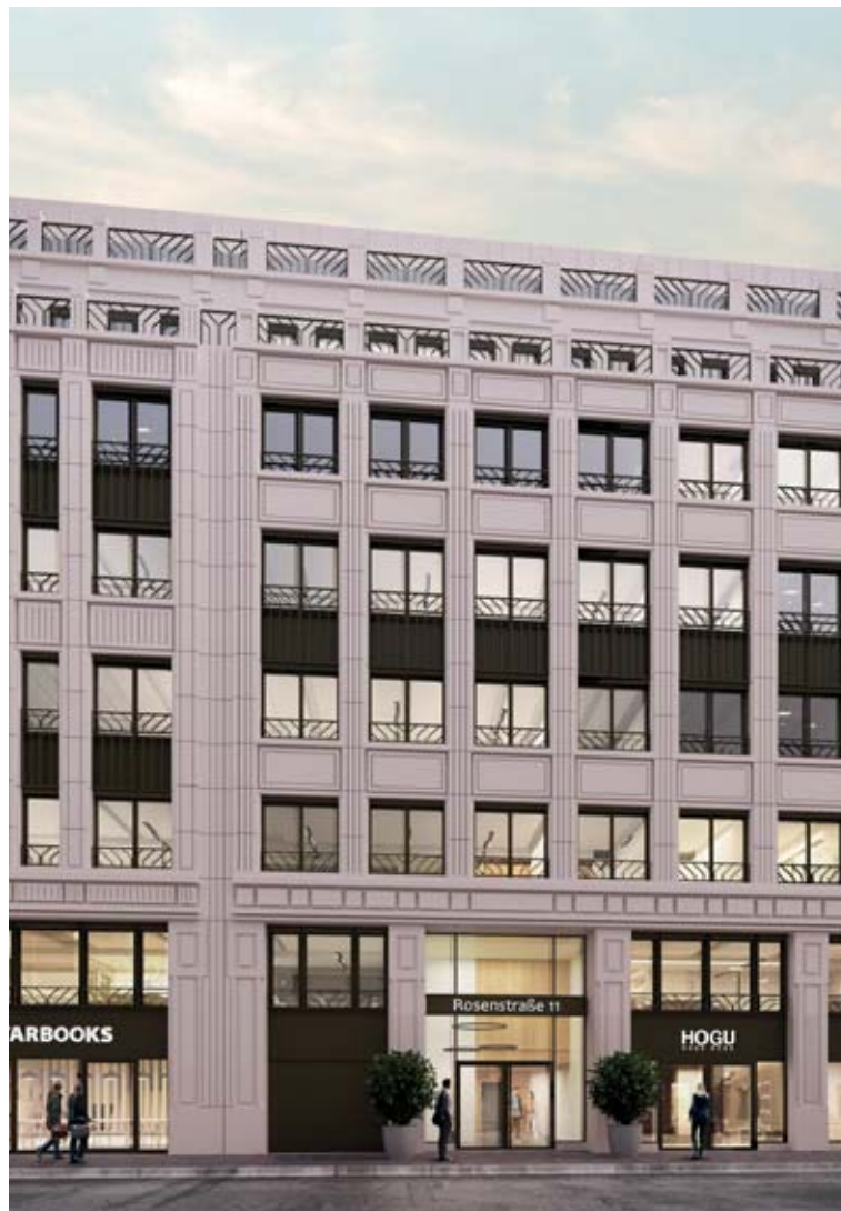
Hambourg, Rosenstrasse 9 (source: planification et présentation – pbr)
