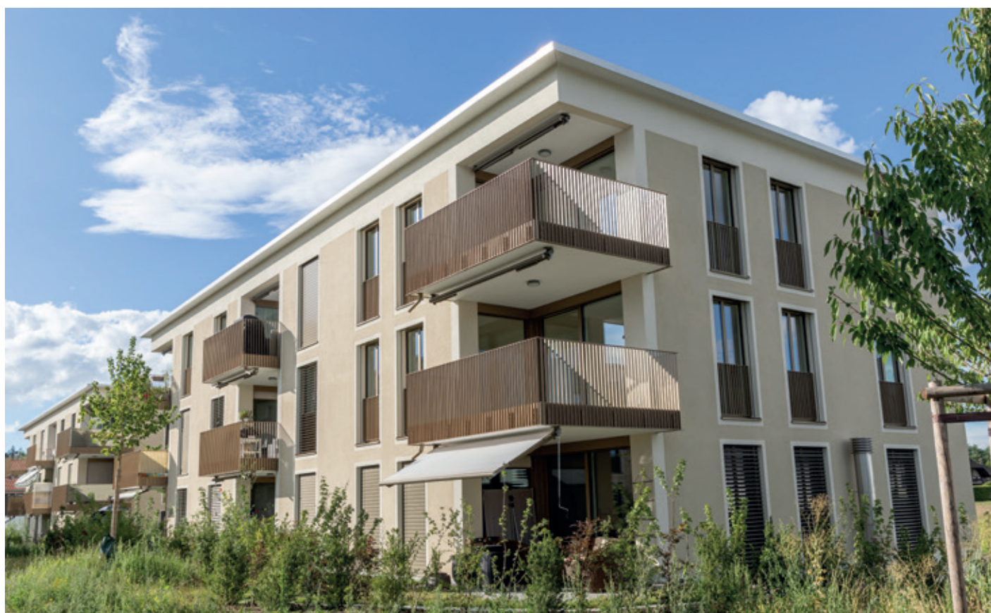
Roggwil, Oberer Freiburgweg 25, 27 / Nussbaumweg 1, 3 / Platanenweg 7, 9
