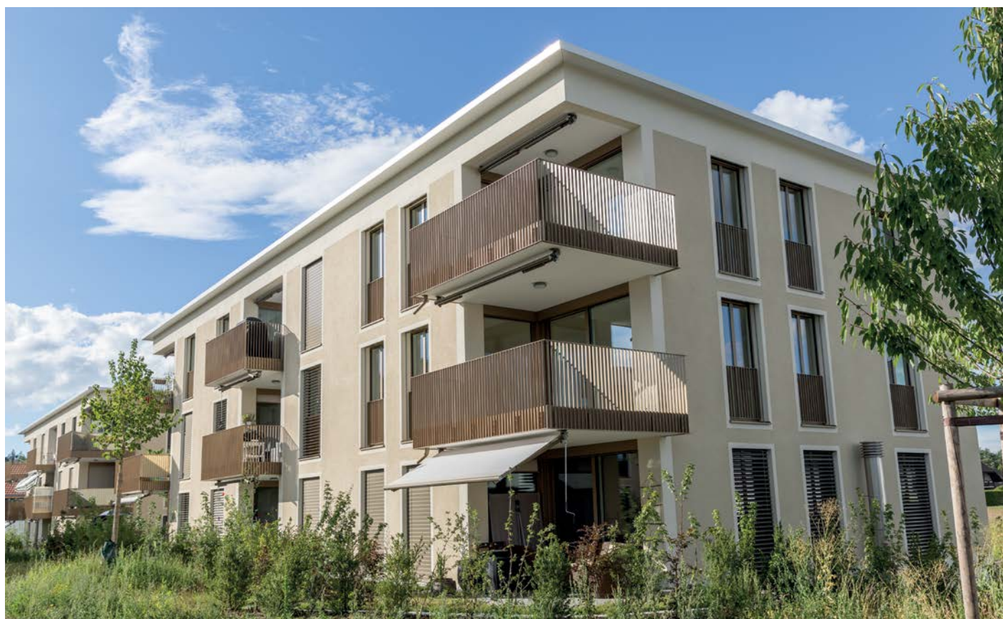
Oberer Freiburgweg 25, 27 / Nussbaumweg 1, 3 / Platanenweg 7, 9, 4914 Roggwil
