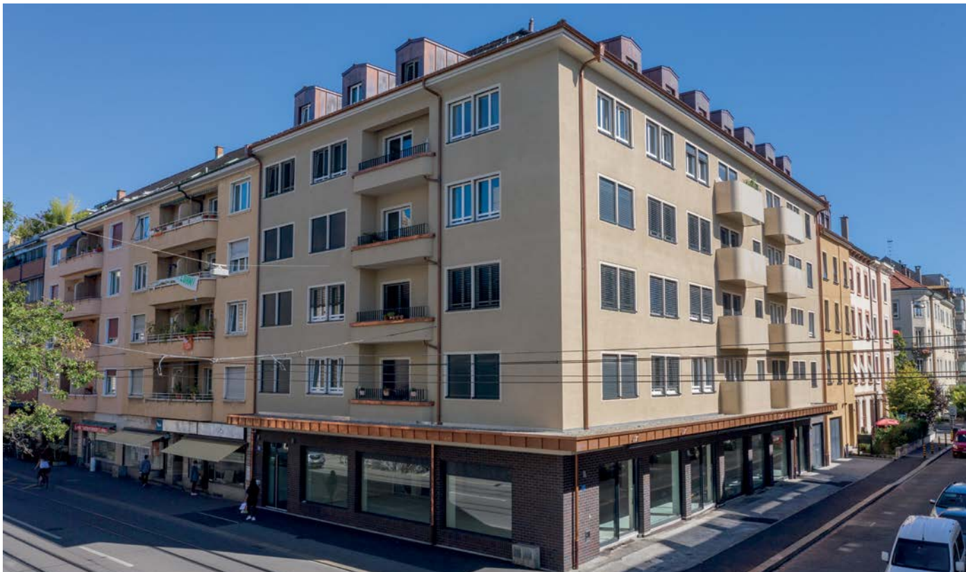
Klybeckstrasse 58 / Haltingerstrasse 5, 7, 4057 Bâle
