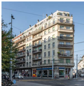
Genf, Rue des Deux-Ponts 18
