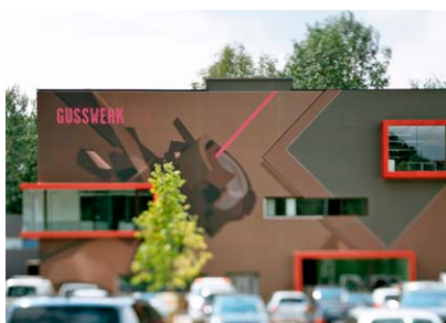
Gusswerk « Esprit », Salzburg
