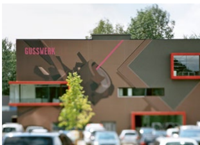
Gusswerk «Esprit», Salzburg
