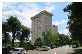
AG, Spreitenbach 4 Poststrasse 180 Valeur vénale: 12'300'000 / App. 49 / SC -
