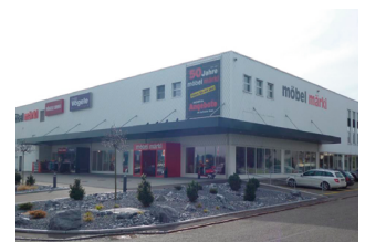
Rickenbach bei Wil, Breitstrasse 5
